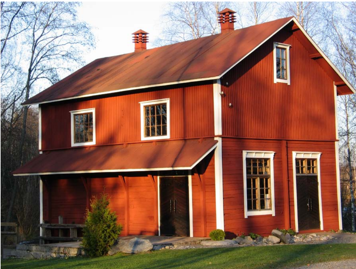
Siikakosken ruismylly maalattiin kesällä 2009 tämän ohjeen mukaan valmistetulla punamultamaalilla. Punamultamaalia kului yhteensä 270 litraa. KUVAT: ANTTI MUTANEN
